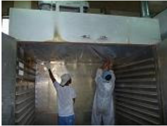
全面ビニール貼り作業
