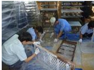
グレーチング剥離作業
